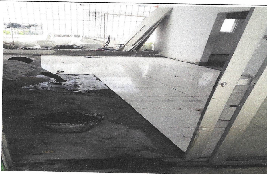
ASSENTAMENTO DE PISO CERÂMICO
