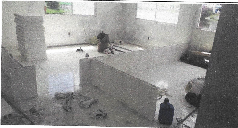
INSTALAÇÃO DE PAREDE DE GESSO
