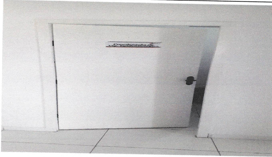
INSTALAÇÃO DE PORTA DE MADEIRA 0,80MX2,10M
