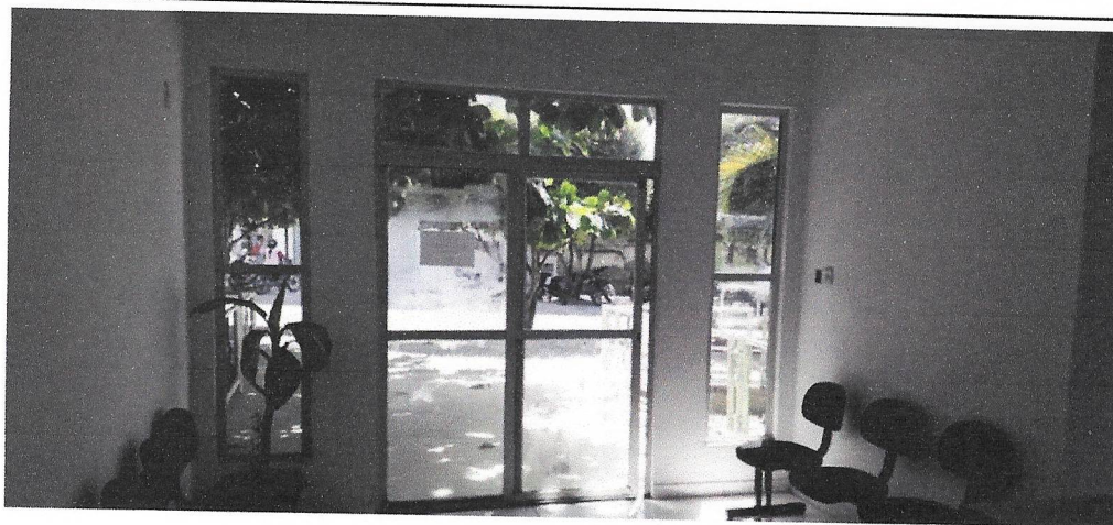
INSTALAÇÃO VIDRO DE JANELA 1,20M X 1,00 M
