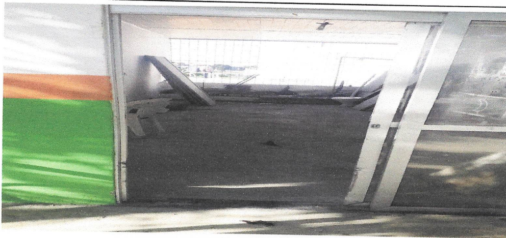
APLICAÇÃO DE MASSA ÚNICA EM PAREDES INTERNAS
