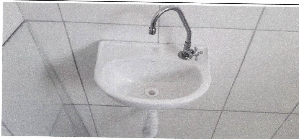
INSTALAÇÃO LAVATÓRIO LOUÇA BRANCA
