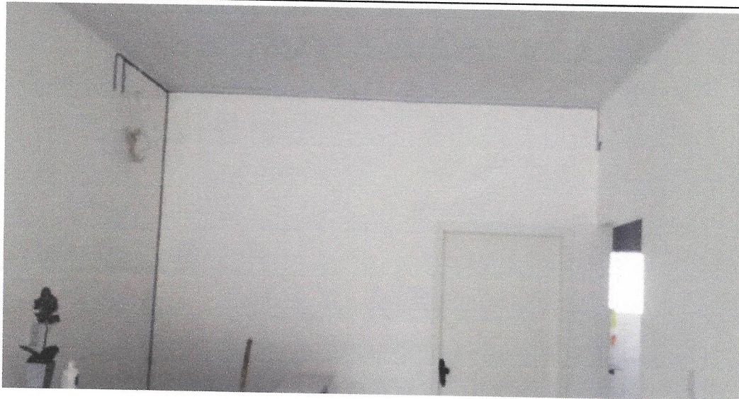
PINTURA INTERNA DE PAREDES
